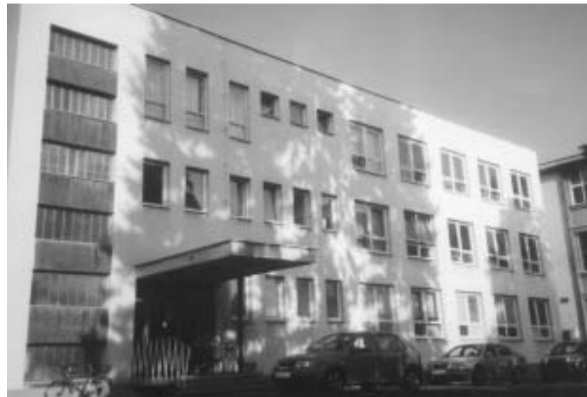
Obr. 10: Nadstavba 2. patra nad přístavbou v r. 1992.
