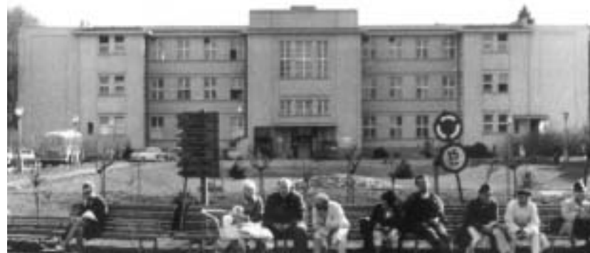
Obr. 3: Kliniky po nadstavbě teras v r. 1948–1949.
